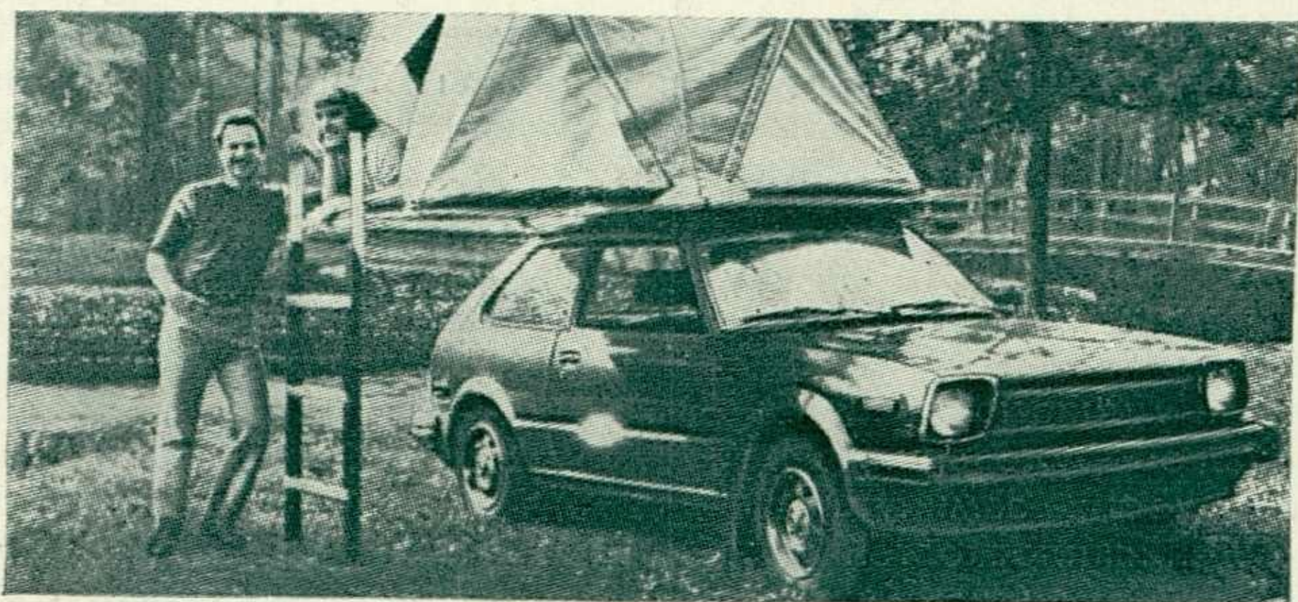
Оригинальную палатку для двоих, располагаемую на крыше малых автомобилей, снабженных верхним багажником, предлагает фирма Oyster Tent Co. (США). Палатка строится на досках, которые кладутся между багажником автомашины и специальной вер-
