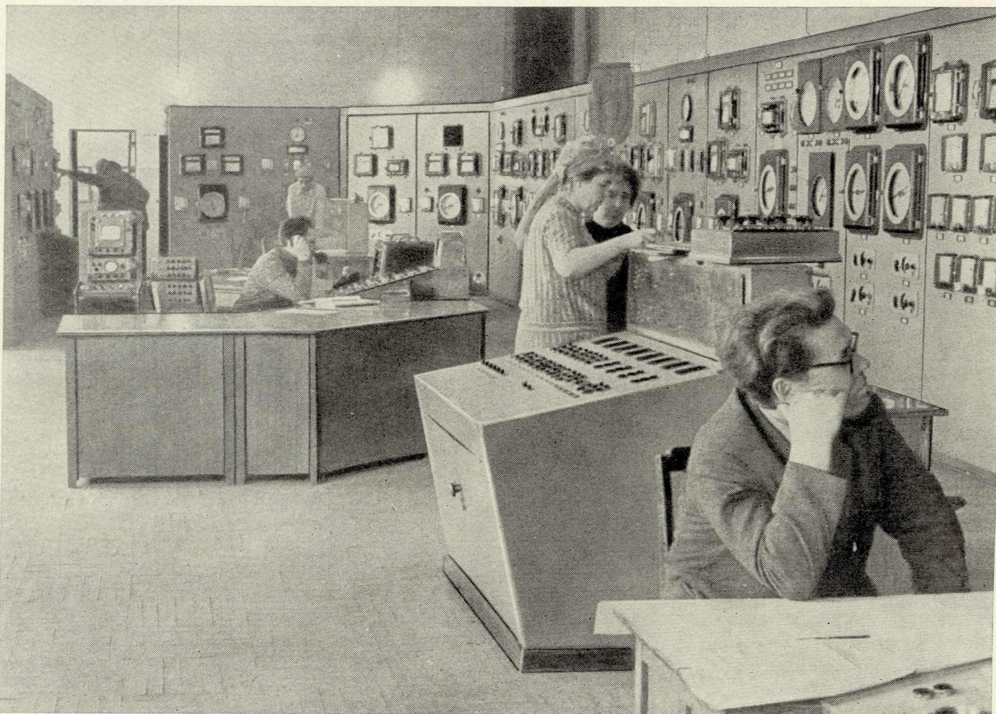
1. Общий вид центрального пункта управления аммиачного производства до реконструкции.
