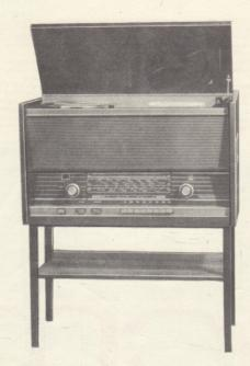
Магниторадиола «Романтика-103» представляет собой универсальный радиокомбайн, состоящий из радиоприемника 1-го класса (3-я модель), магнитофона и электропроигрывающего устройства.
