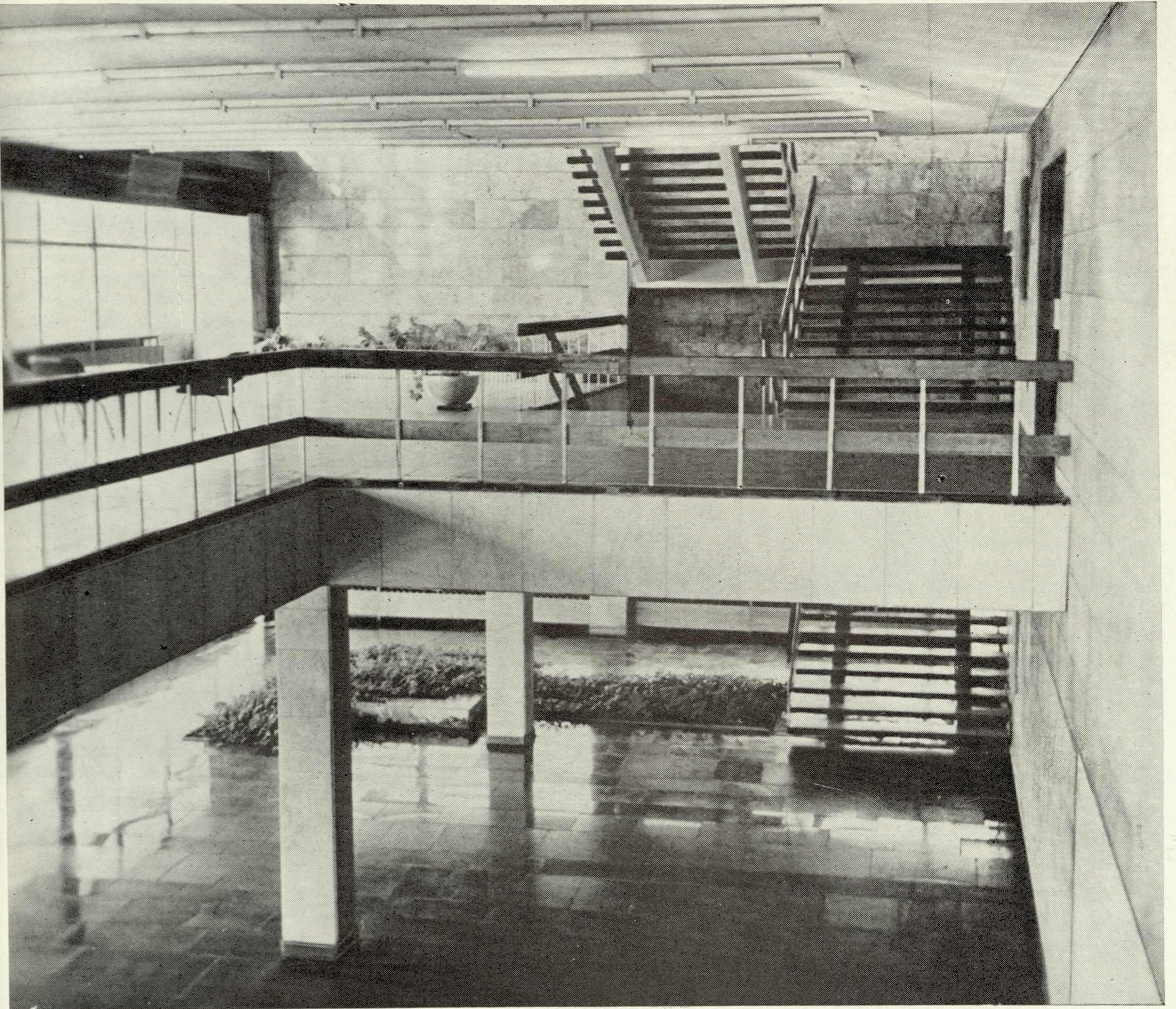
6. Гардеробно-душевой блок в корпусе вспомогательных цехов 7. Корпус вспомогательных цехов. Вестибюль пристройки административно-бытовых помещений. Для покрытия пола и облицовки колонн применены мраморные плиты, для стен — травертин
