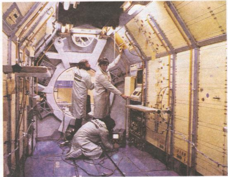
Космический дизайн в проектировании оборудования. Испытание прототипа оборудования (для астронавтов-исследователей) в лабораторном отсеке блока «Спейслэб» (США)
