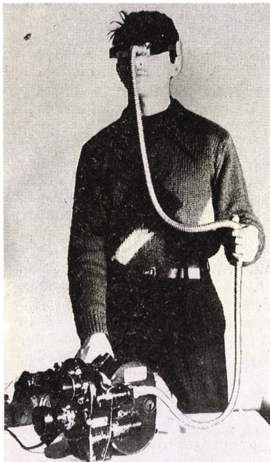
Рис. 3. Гибкое беспараллаксное визирное приспособление в рабочем положении
