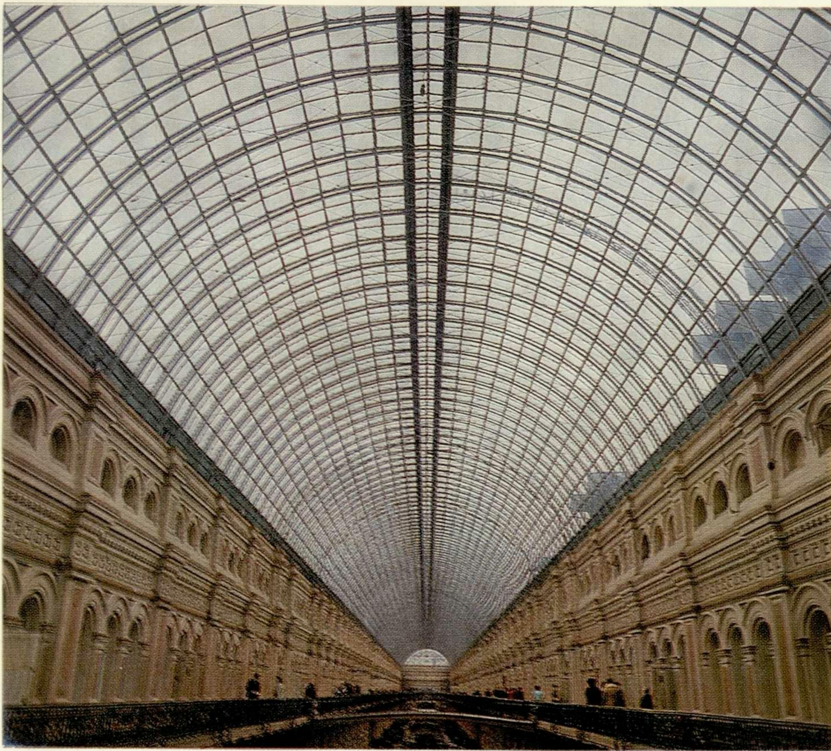
11. Конструкция перекрытия ГУМа. Пример инженерно-технической стержневой конструкции
