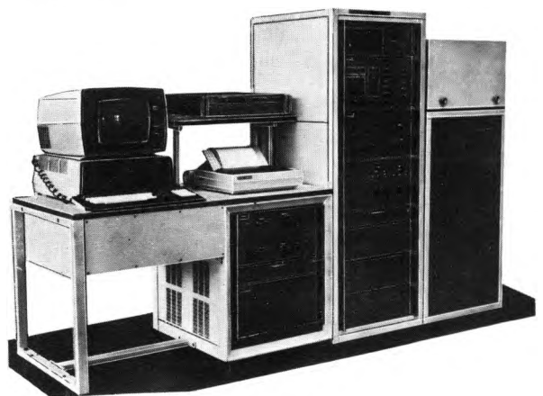
Рис. 13. Автоматизированная установка «Мальт-1» для массового контроля температурной стабильности магнитной индукции на оси кольцевых магнитов
