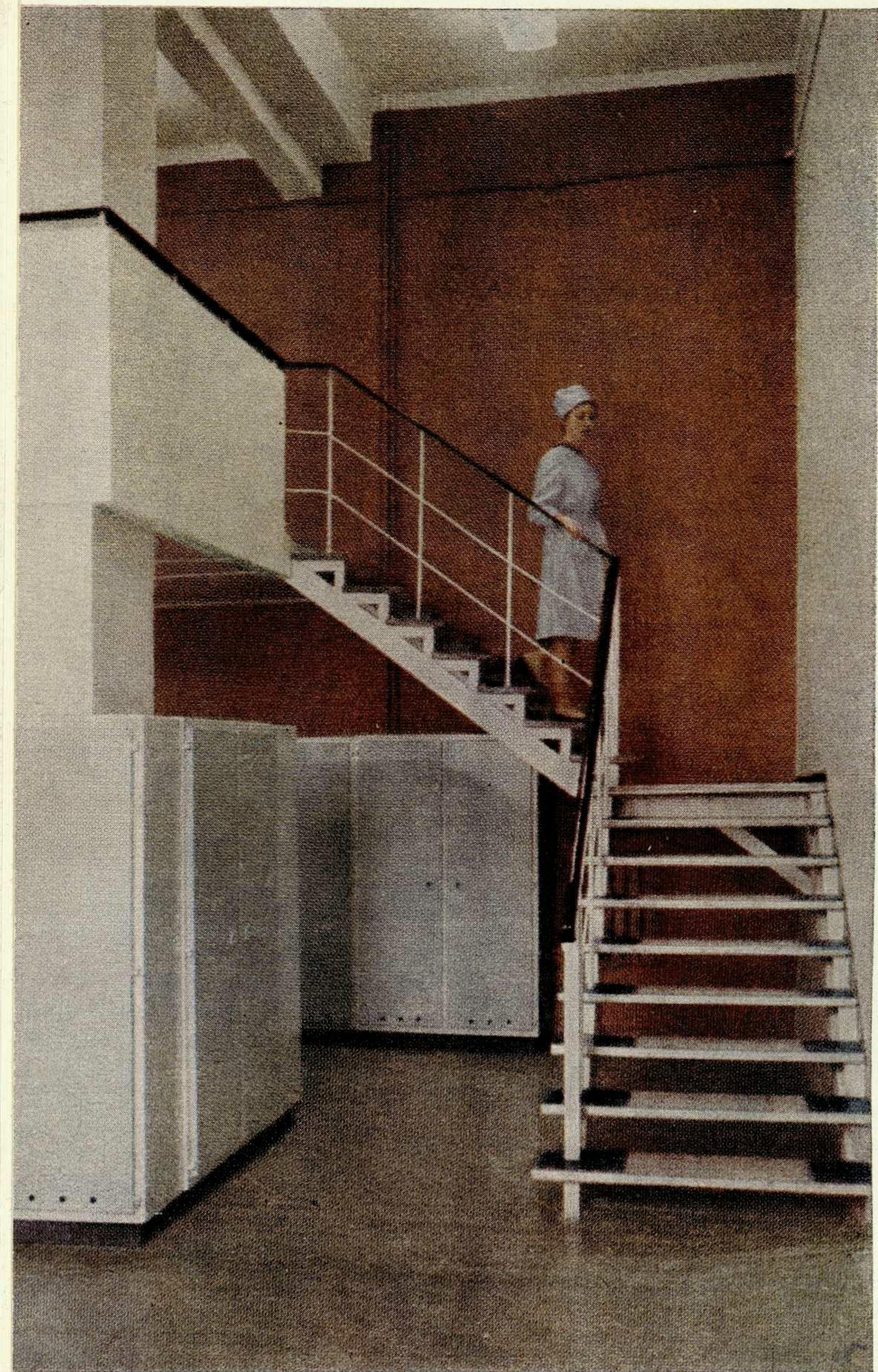
Избыточная высота бытового помещения использована для организации антресоли.
