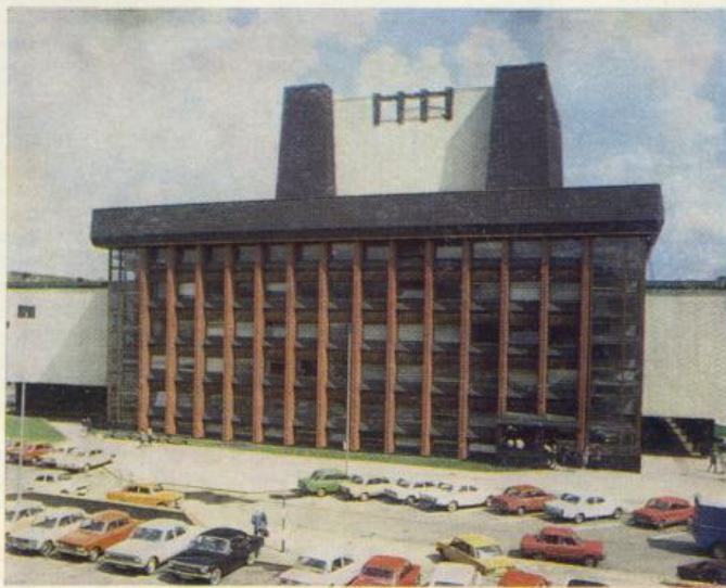
1. Фасад Театра оперы и балета в Вильнюсе. Несущие конструкции здания отделаны фасадной керамической плиткой
