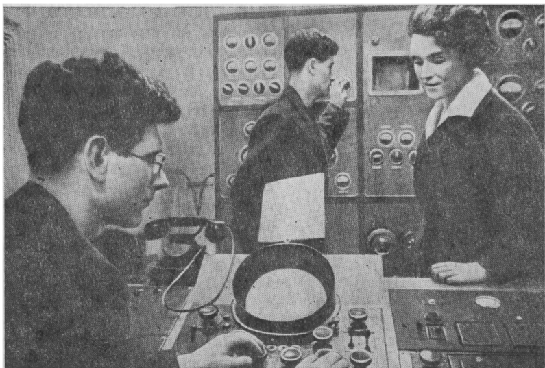
Настройка Опытного ленинградского телецентра
