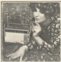
На первой странице обложки — новый малогабаритный супергетеродинный радиоприемник III класса «Россия», предназначенный для приема радиовещательных станций в диапазонах длинных, средних и коротких волн. Радиоприемник «Россия» изготовлен на базе приемника «Сokol-4». Он почти не претерпел существенных изменений за исключением мелких доработок (кассета для батарей, телескопическая антенна). В 1970 г. Челябинский радиозавод выпустит 80 тыс. радиоприемников «Россия».
