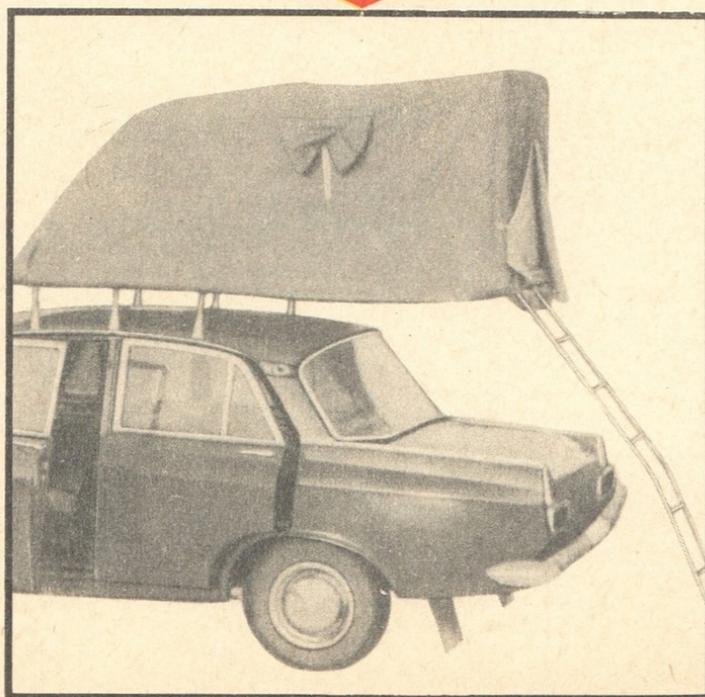
Правдинский завод радиорелейной аппаратуры подготовил к серийному производству универсальный автомобильный багажник-палатку. Он предназначен для транспортировки груза во время движения, а на стоянке может превращаться в палатку на два спальных места. Багажник-палатка может быть установлен на всех легковых автомобилях, выпускаемых нашей промышленностью.
