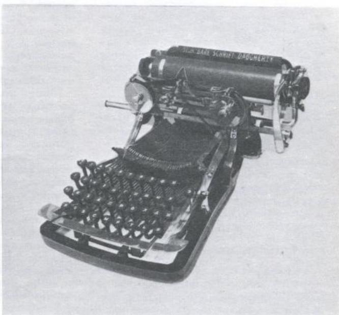
6. Модель «Даугерти» — первая в мире пишущая машинка с передним ударом по валу. С ее появлением текст стал виден в процессе печатания, облегчилась работа машинистки, контроль за правильностью текста. Конструкция разработана в 1890 году, производство под разными названиями продолжалось до 1923 года
