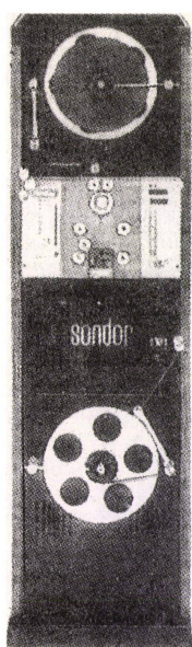
Sondor oma S — мастер-аппарат записи и воспроизведения фонограмм
